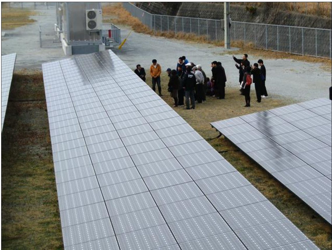
発電所内に設置されている太陽光パネルを使い、説明
