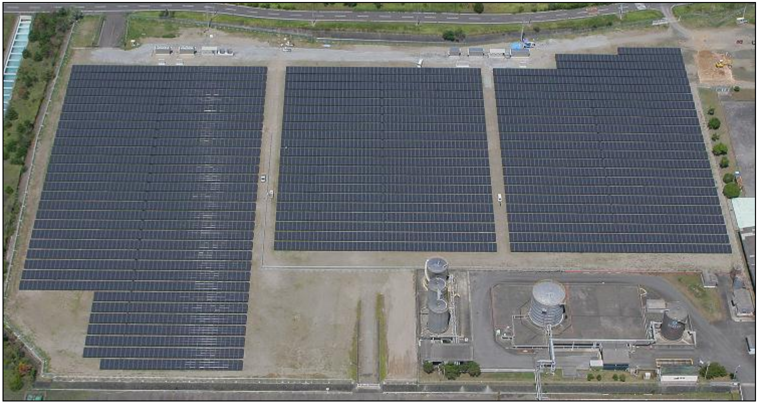
<「ENEOSグローブ 薩摩川内太陽光第一発電所および第二発電所」全景>
